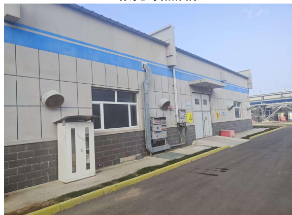
依托危废暂存间
